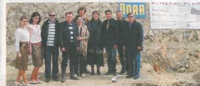
Mitte April wurde der Grundstein für den neuen Gebäudekomplex gelegt. Bis zum Frühjahr 2011 soll alles fertig sein.
